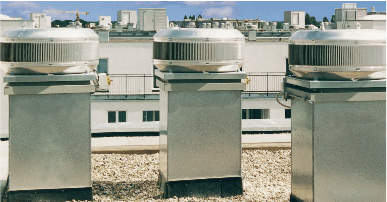
Dachventilatoren bieten eine einfache und kostengünstige Art der mechanischen Lüftung
