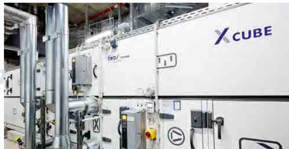
Insgesamt 30 X-CUBE RLT-Geräte versorgen das Gerber mit 450.000 m 3 /h aufbereiteter Frischluft.
