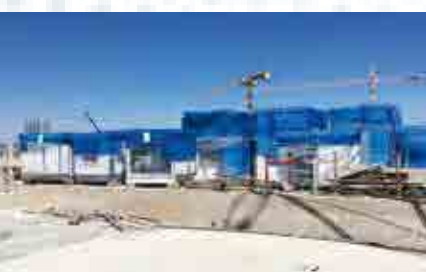
In Johannesburg entsteht eine riesige Shopping-Mall.
