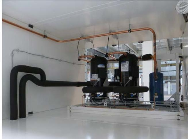
Verdichter im RLT-Gerät
