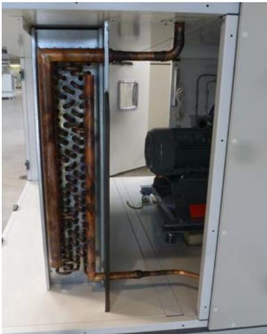
*Kondensator im RLT-Gerät*
