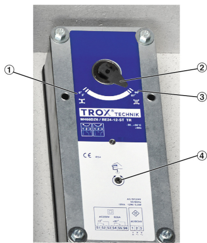
Abb. 39: AUF-ZU-Stellantrieb (Entrauchungsklappe geöffnet)
