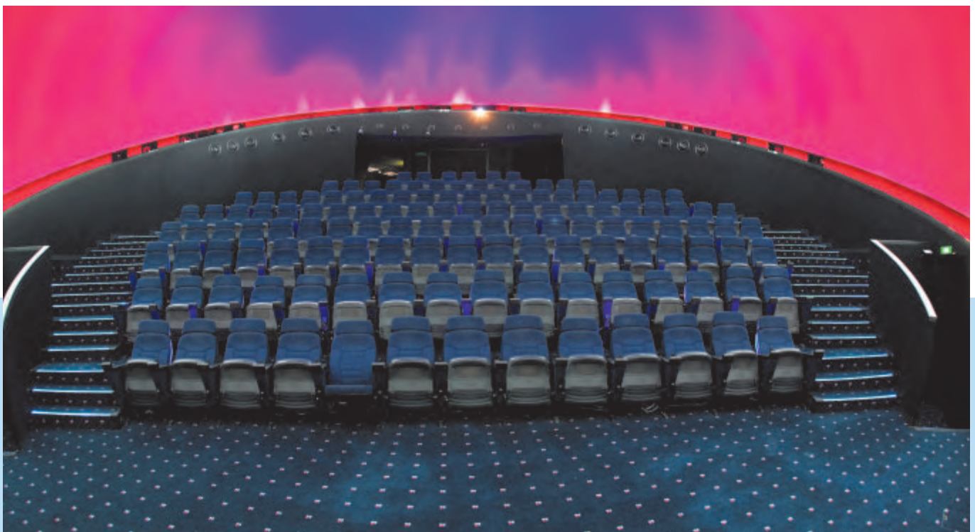
Tholos-Theater, Athen, Griechenland Nur-Luft-System mit Stufendralldurchlässen und Weitwurfdüsen
