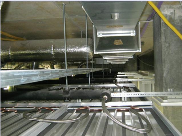
Kühldeckenplatten mit vollflächigem Akustikvlies
