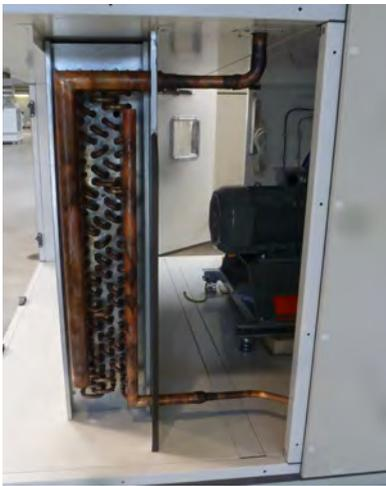
*Condenseur dans une centrale de traitement d'air*
