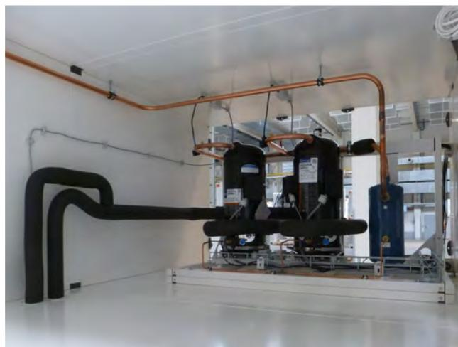
*Compresseur dans la centrale de traitement d'air*
